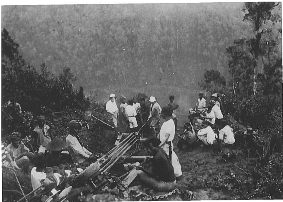
▲ Foto 3 Spannen van een kabel over de kloof van Malabar.
